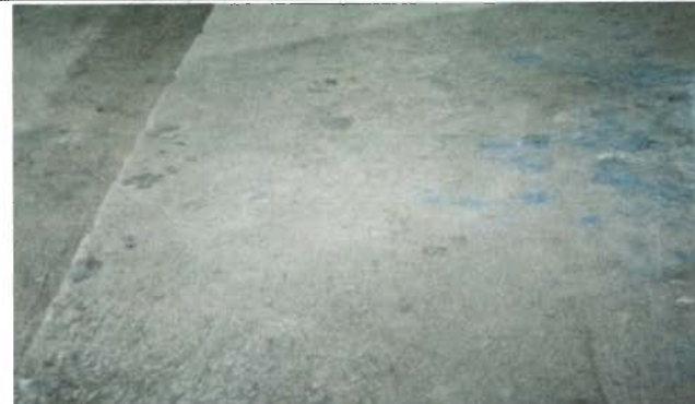
Foto 8: Sustitución de losa de patio Modulo 1
