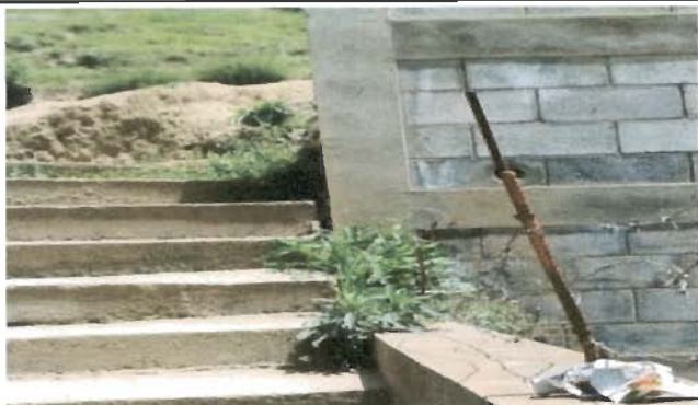
Foto 7: Reparación de muro perimetral Modulo 2
