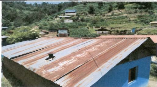
Foto1: Sustitución de lamina por lamina troquelada Modulo 1
