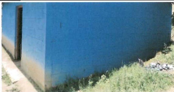
Foto 11: Reparación de muro de cocina Modulo 1
