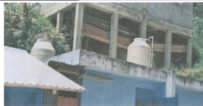
Foto 12: Sustitución de deposito de agua Modulo 2
