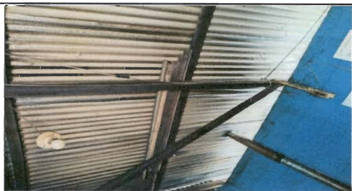
Foto 5: Sustitución del sistema electrico Modulo 1
