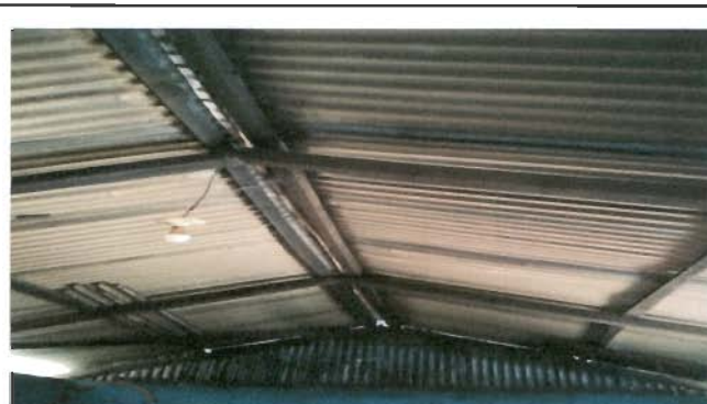
Foto 2: Sustitución de estructura de soporte de madera por metal en el techo Modulo 1
