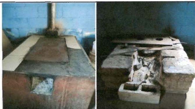
Foto 9: Sustitución de dos estufas rural (completa) incluye chimenea y plancha de metal Modulo 1
