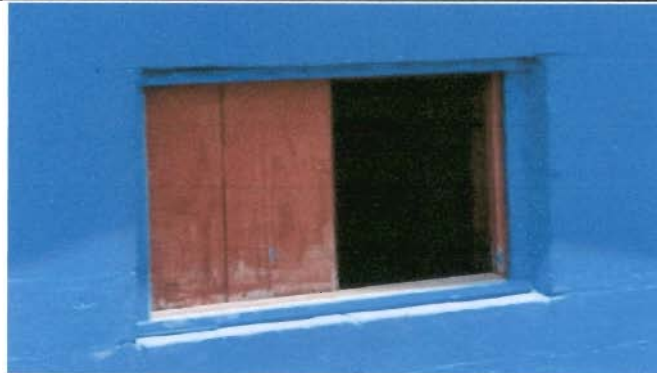
Foto 4: Sustitución de ventena de madera por metal Modulo 1
