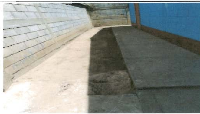
Foto 10: Reparación de repello y cernido de muro Modulo 2
