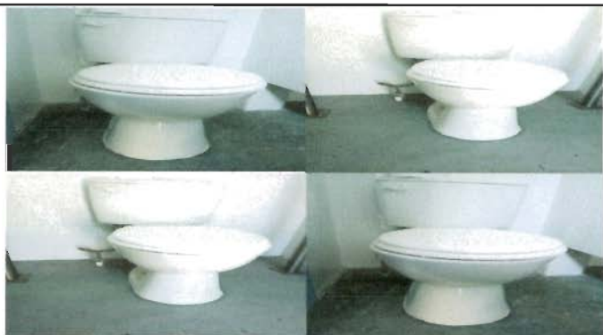
Foto 13: Sustitución de accesorios de inodoro Modulo 3
